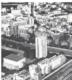
Tour Poissonniers, bâtiment de Raymond Lopez (1958)
