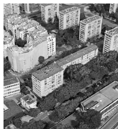
Logements Porte de Vincennes (1959)
